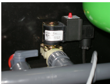
Abb. D-5: Ausspülventil montieren
